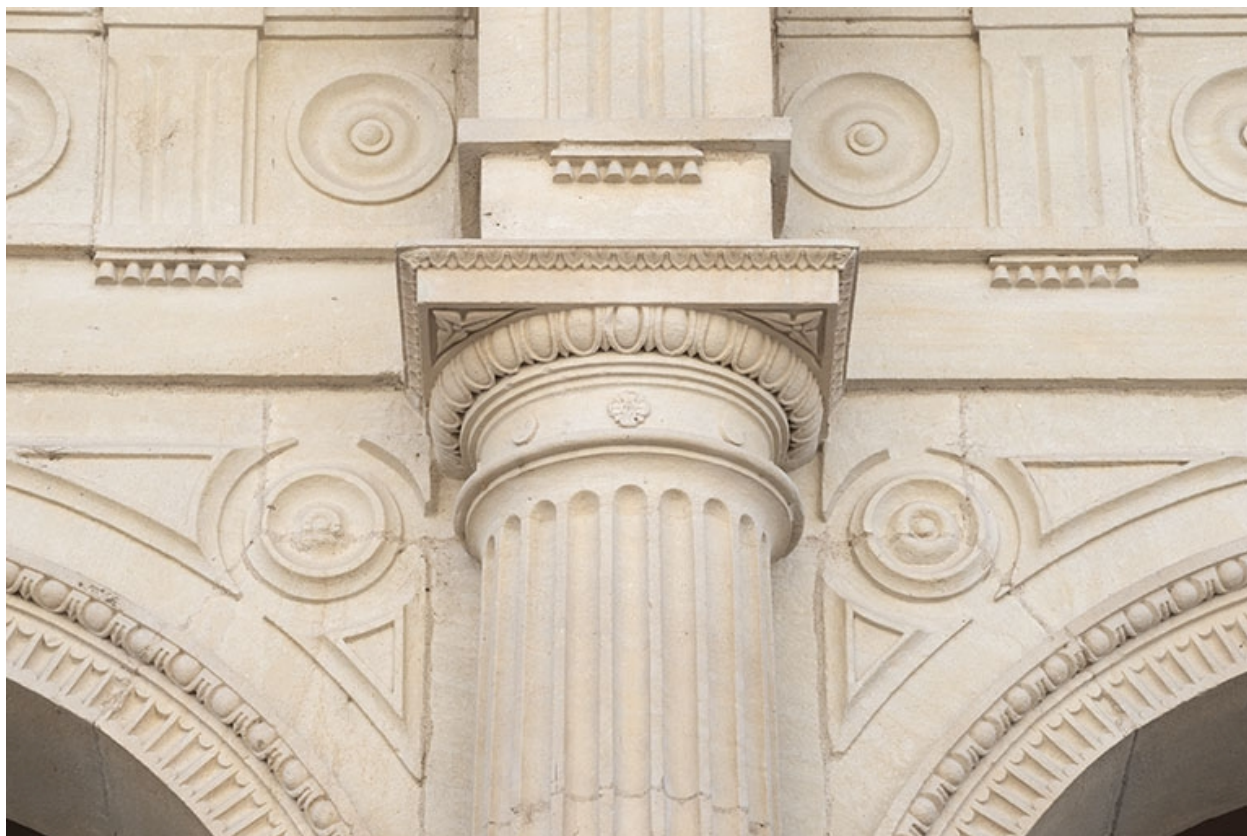
Façade antérieure, rez-de-chaussée : chapiteau dorique.
