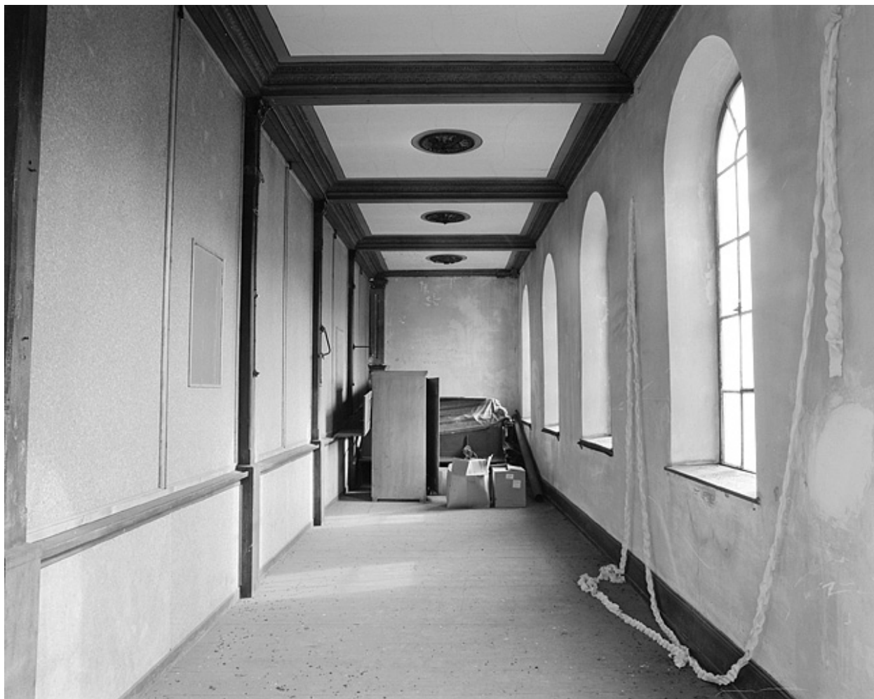
Vue intérieure de la tribune sud.
