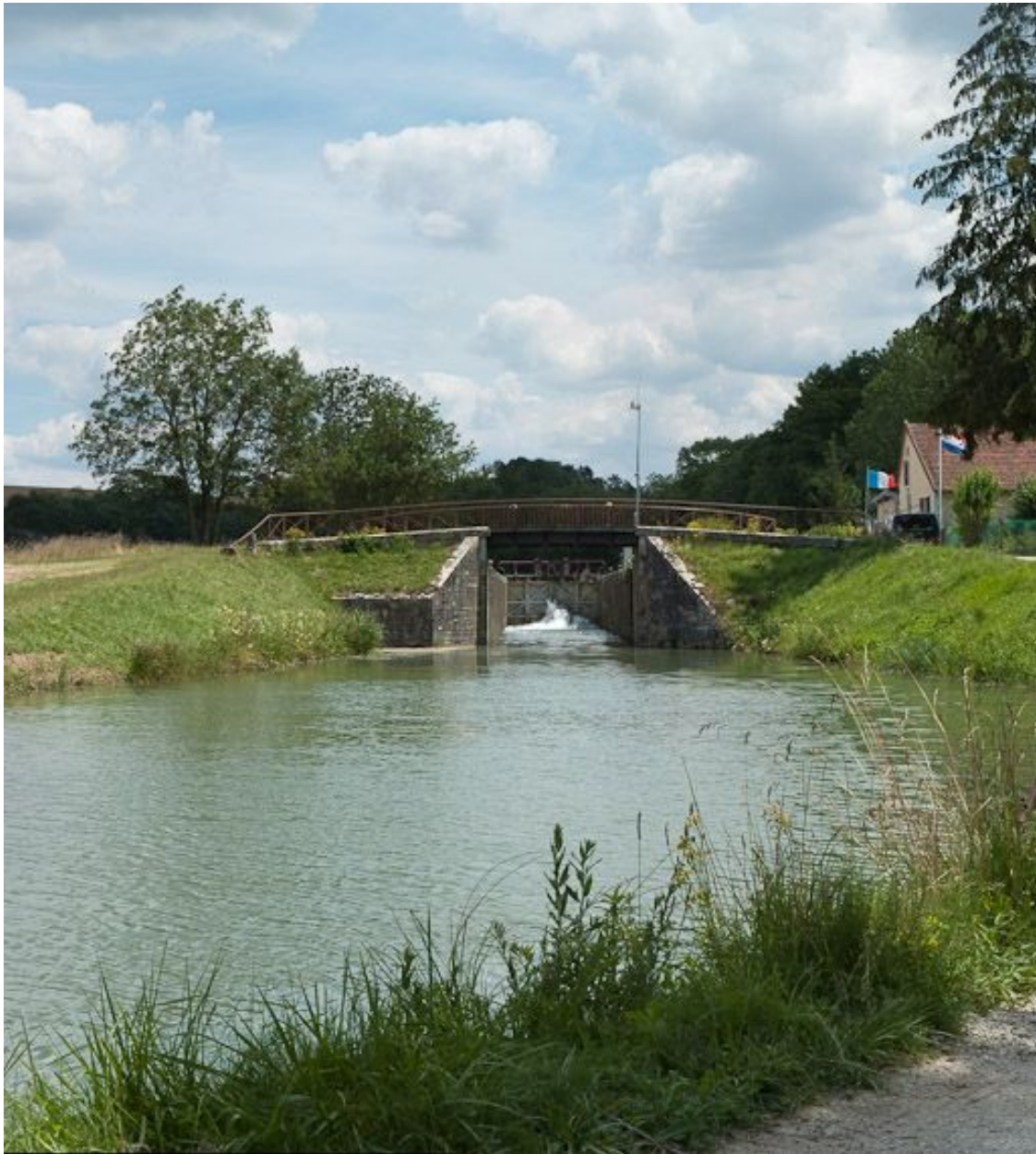
Vue du pont depuis l'aval.
