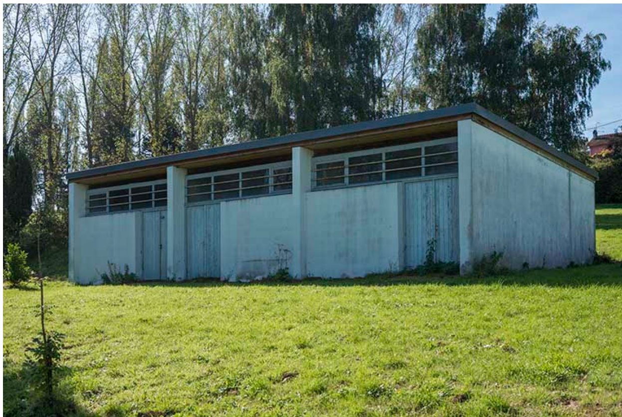
Angle nord-ouest et façade nord-est du dépôt.
