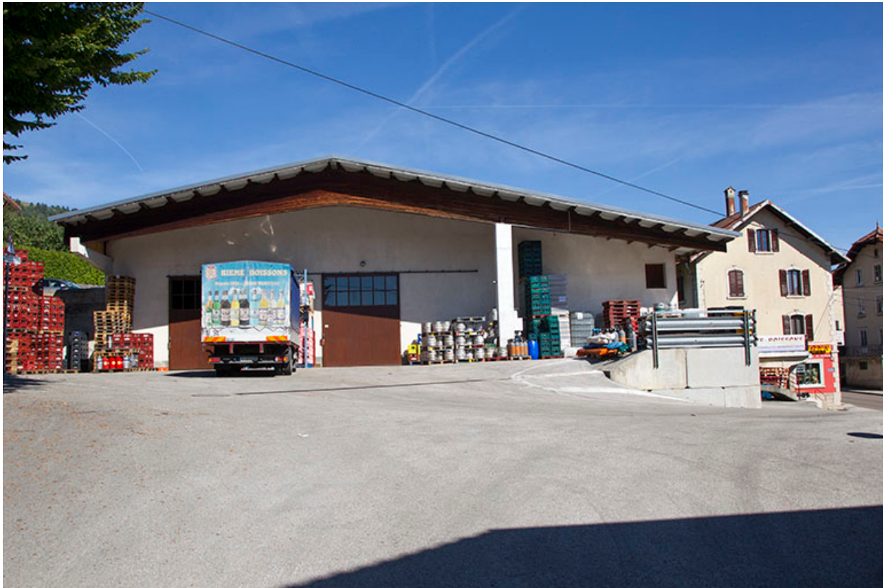
Grand entrepôt, depuis le sud.
