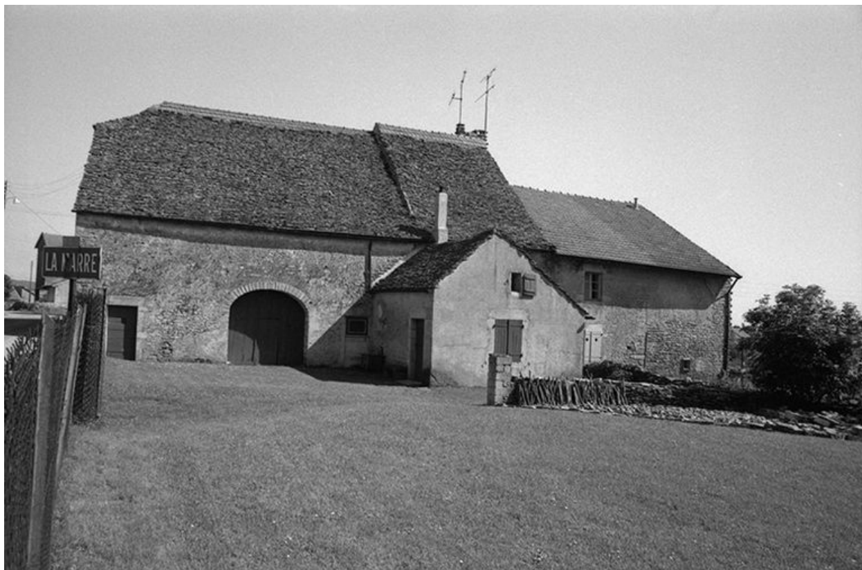
Ferme cadastrée 1957 A1 287 et 293 : vue d'ensemble.
