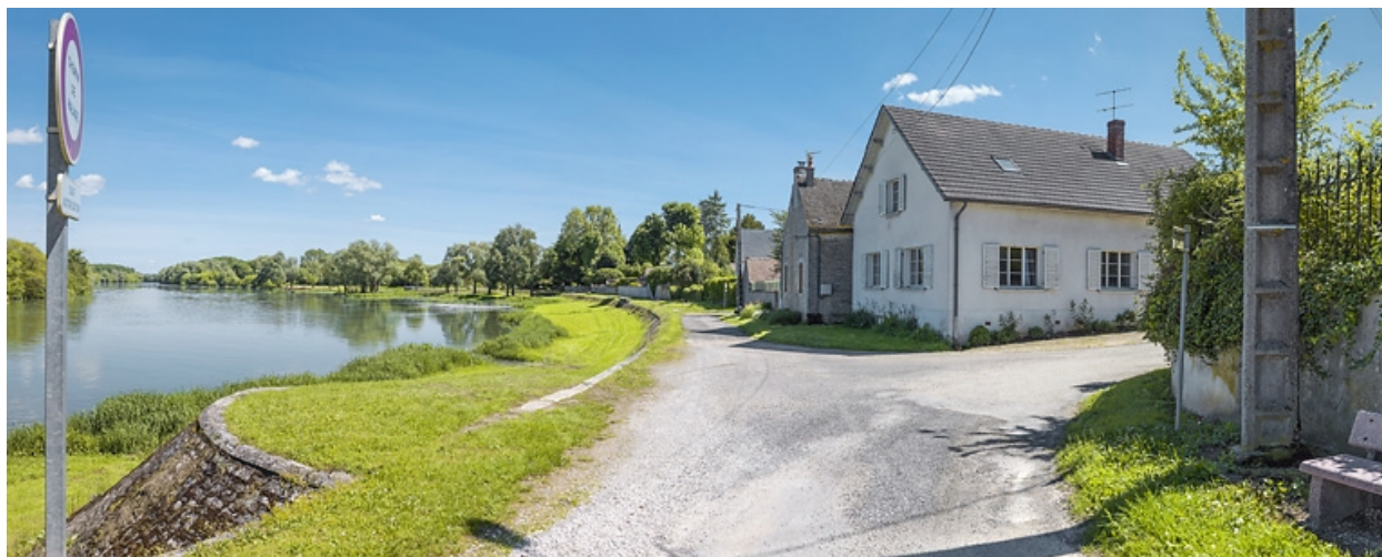
Tête aval de la digue.
