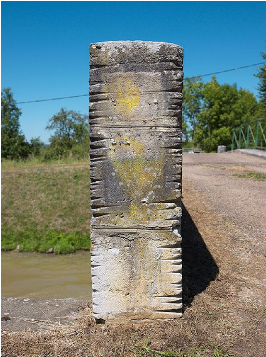
Détail des marques de halage.
