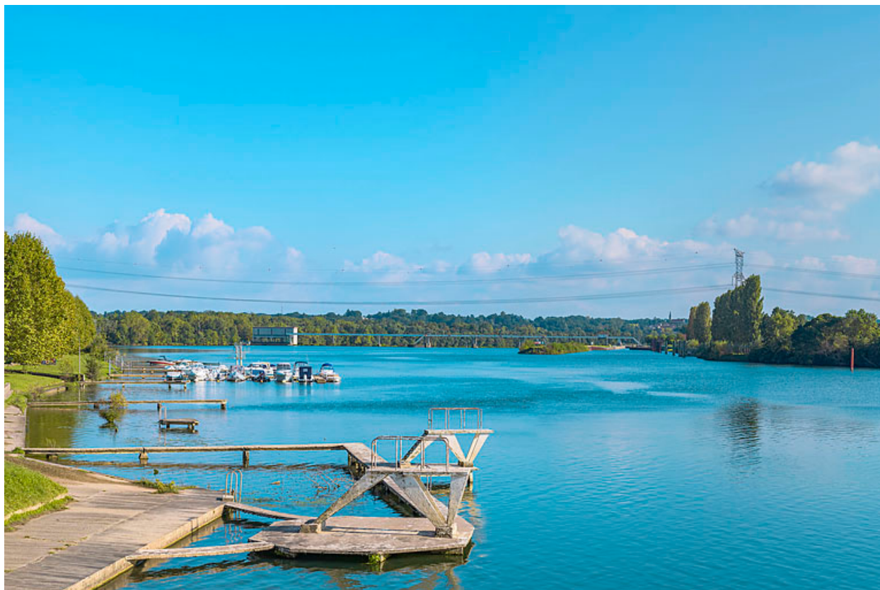
Le barrage de Dracé vu depuis Thoissey.
