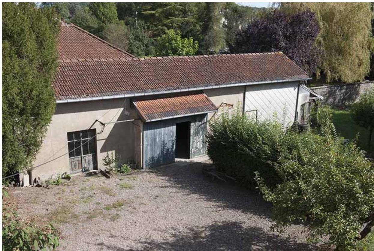
Vue générale de la remise.
