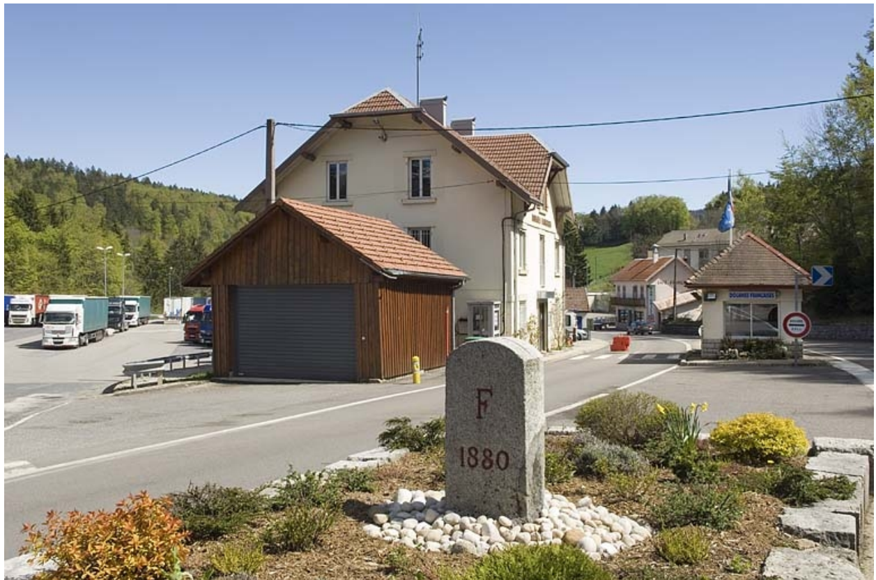
Vue d'ensemble des bâtiments de la douane.
