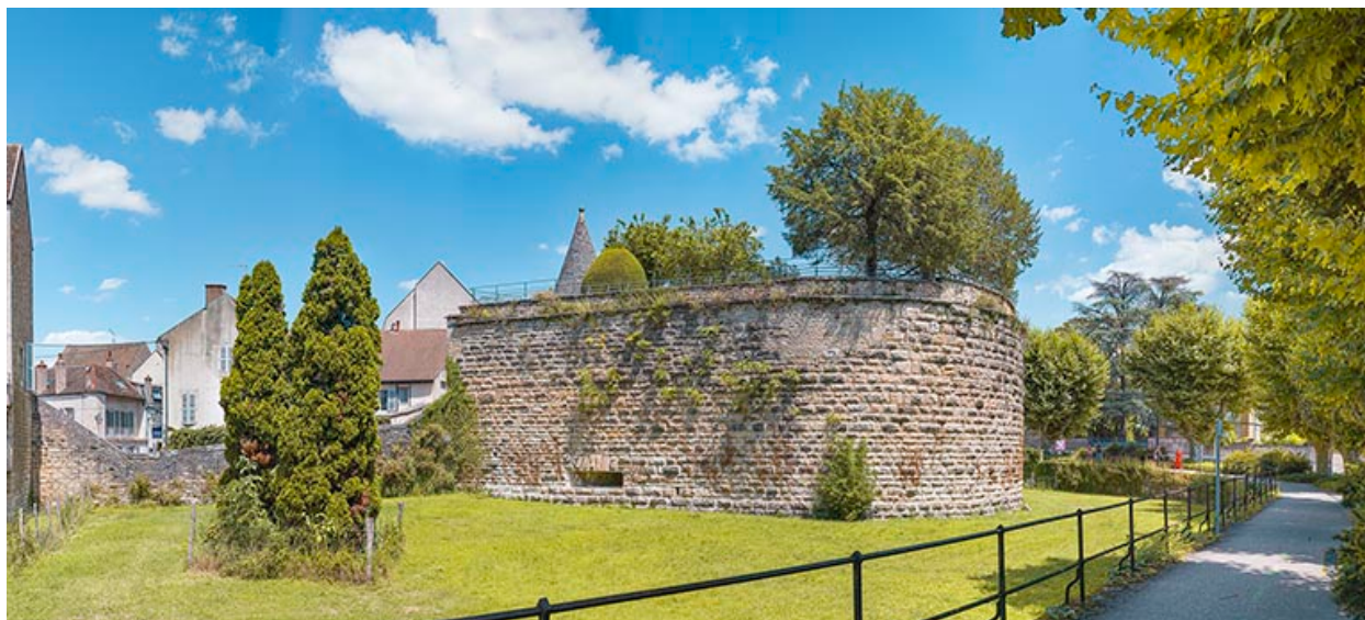
Vue générale depuis le boulevard Perpreuil.
