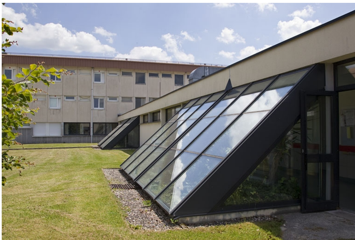
Bâtiment de la restauration : face nord.
