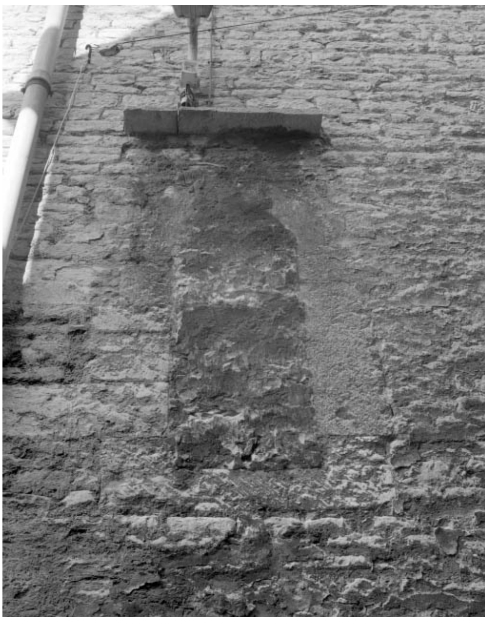
Façade latérale gauche : détail d'une baie murée.
