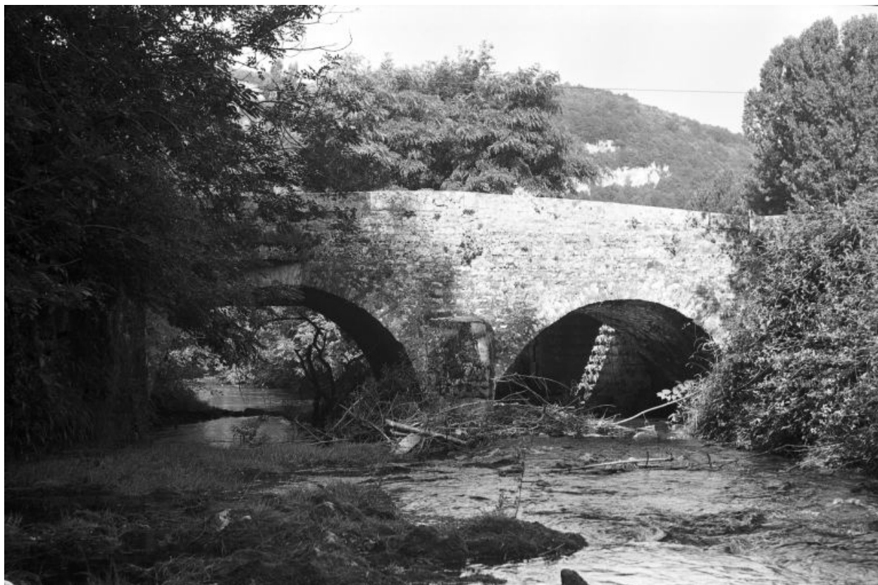
Pont situé route de la Vallée.
