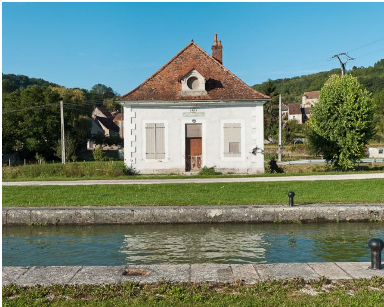
Vue de face de la maison éclusière.
