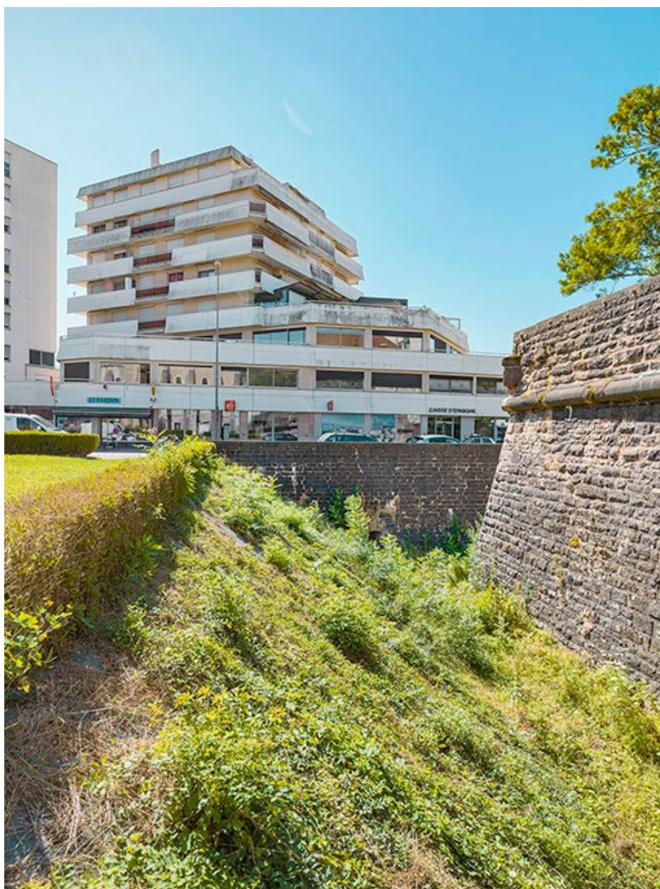
Le bastion Royal après restauration.
