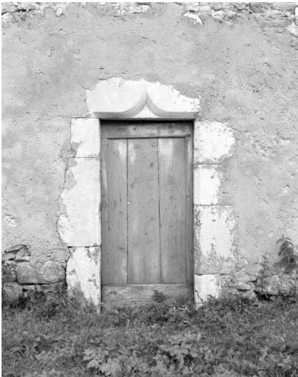
Porte d'accès à l'étable.
