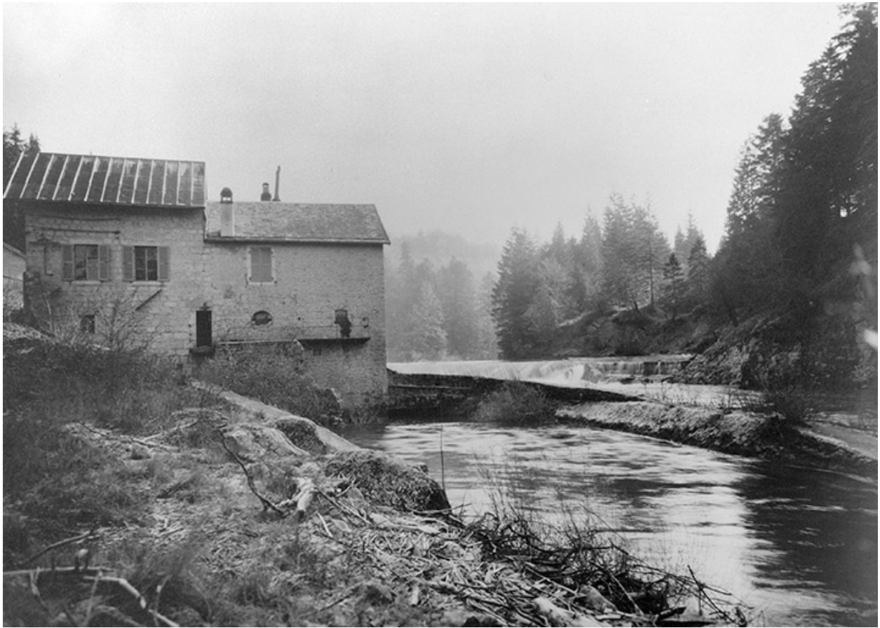
[Centrale hydroélectrique de la Roche] Vue générale, 1950-1951.
