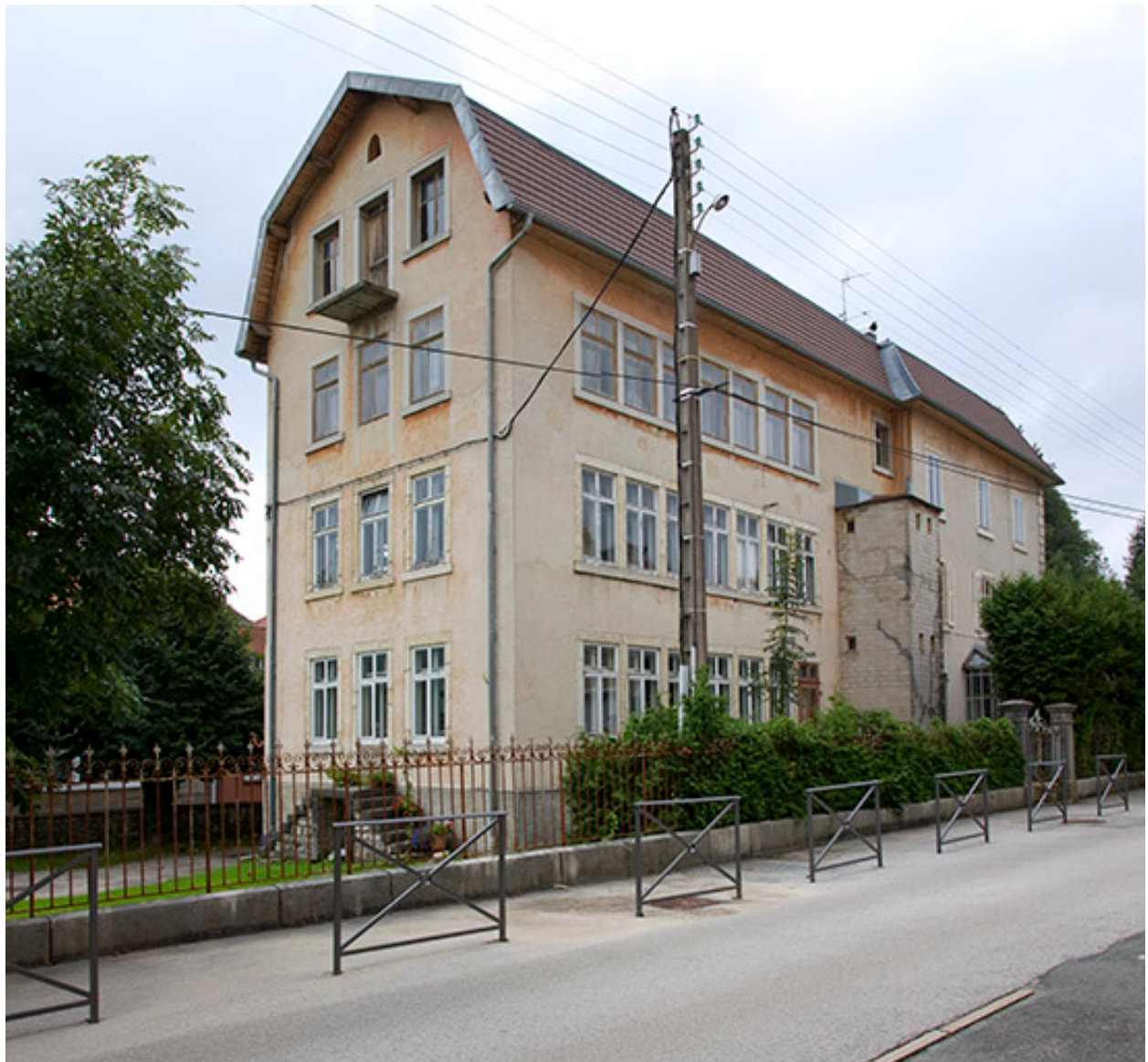
Usine : façades postérieure et latérale droite.
