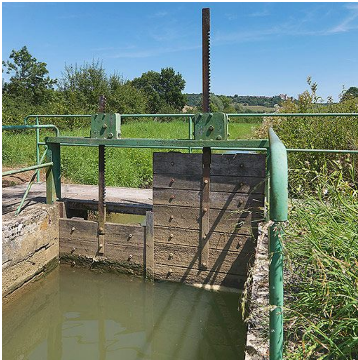
Vannes de régulation sur la rigole.
