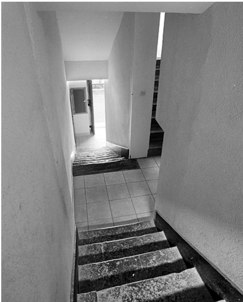
Maison au n° 32 : escalier.
