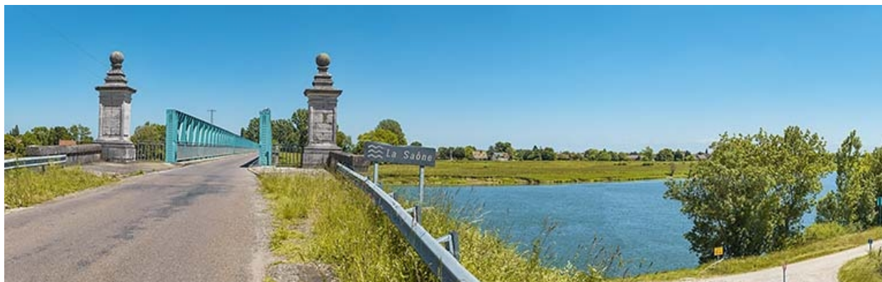
Entrée du pont.
