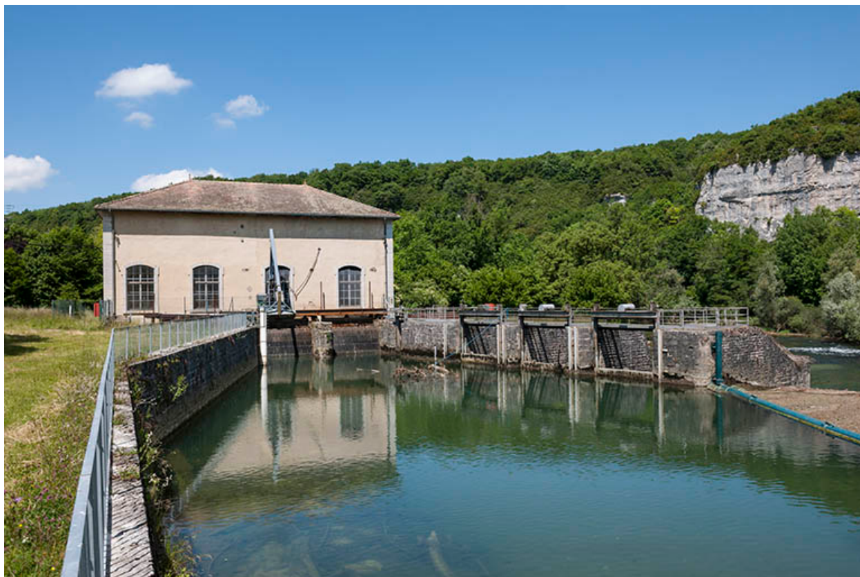
La centrale et son déversoir, depuis l'amont.
