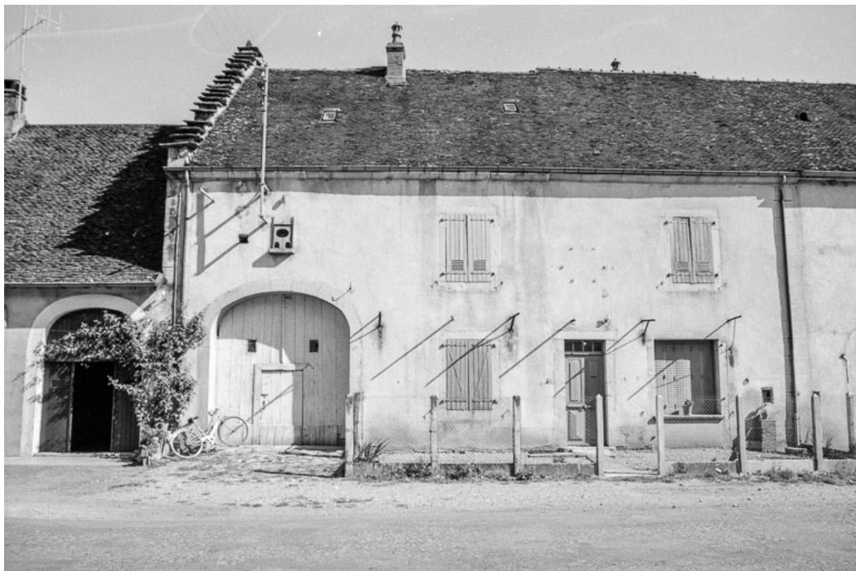
Ferme : façade antérieure.
