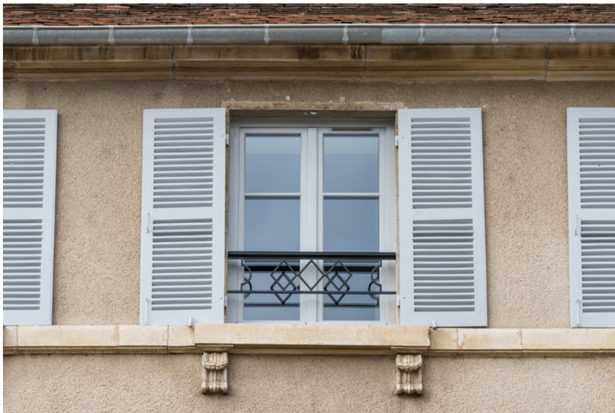
Façade antérieure : fenêtre du 2e étage.
