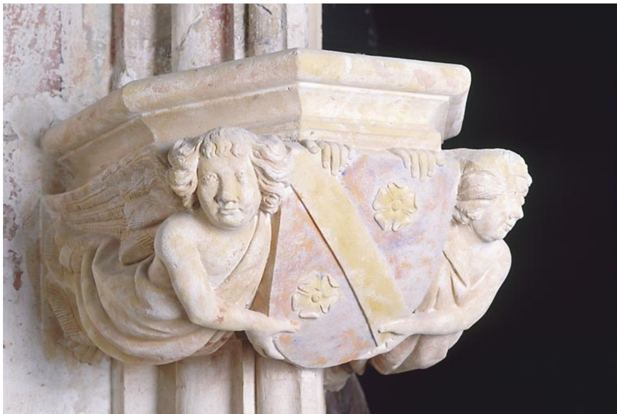
Console nord-ouest, vue de trois quarts.
