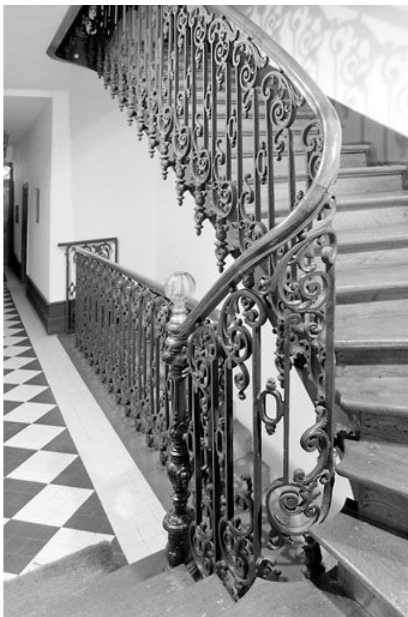
Escalier tournant, depuis l'extrémité du couloir.
