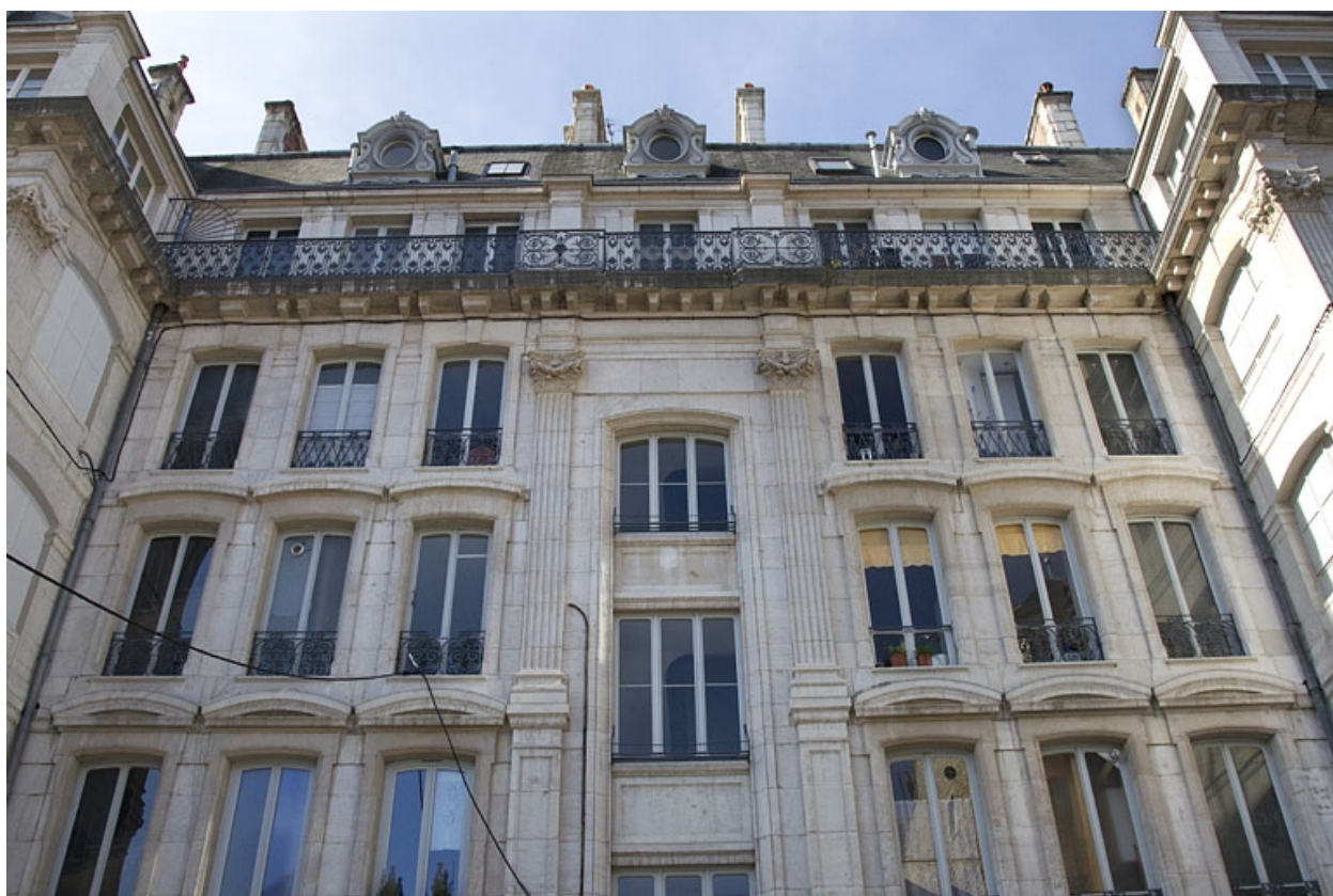
Vue de la façade postérieure.
