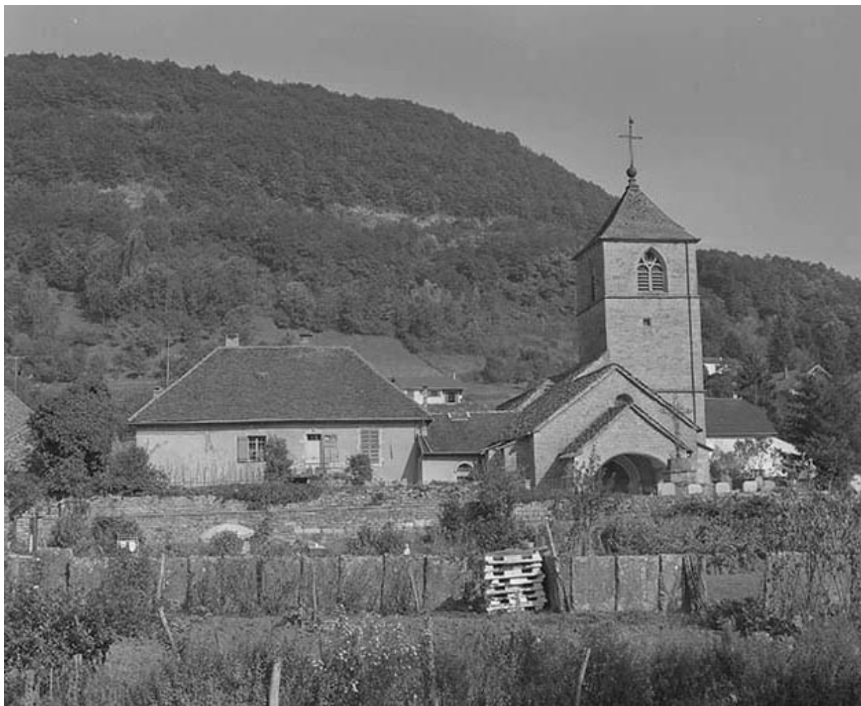
Extérieur : façade antérieure en 1978.
