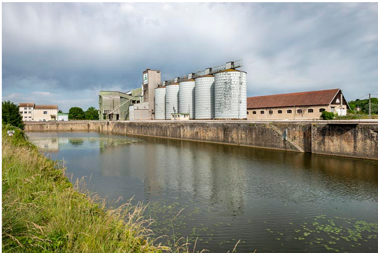
Bassin de l'ancienne gare fluviale.
