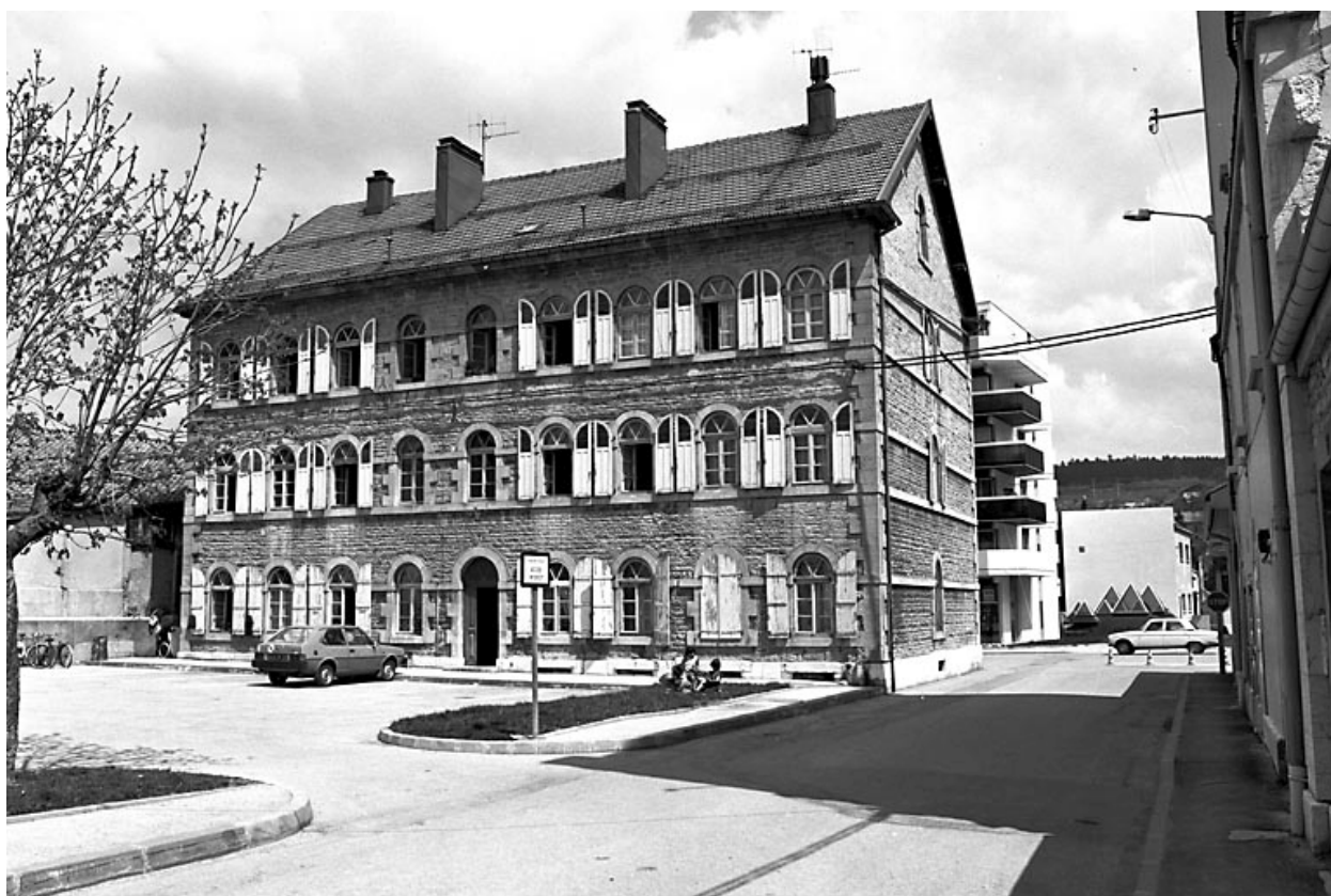
Caserne située place des Bernardines.
