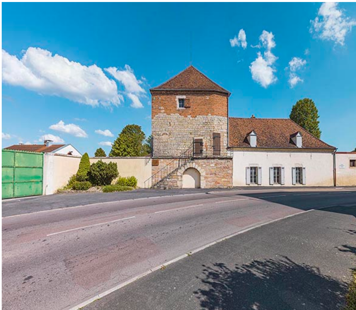
La tour Belvoir, face côté gorge.
