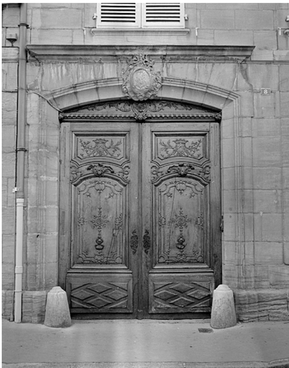
Portail de la façade antérieure.
