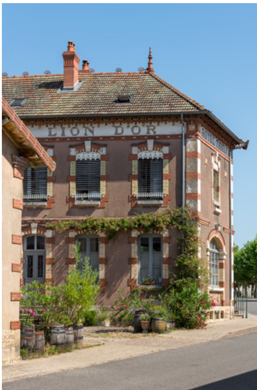
Hôtel-restaurant, vu du sud (vue rapprochée).
