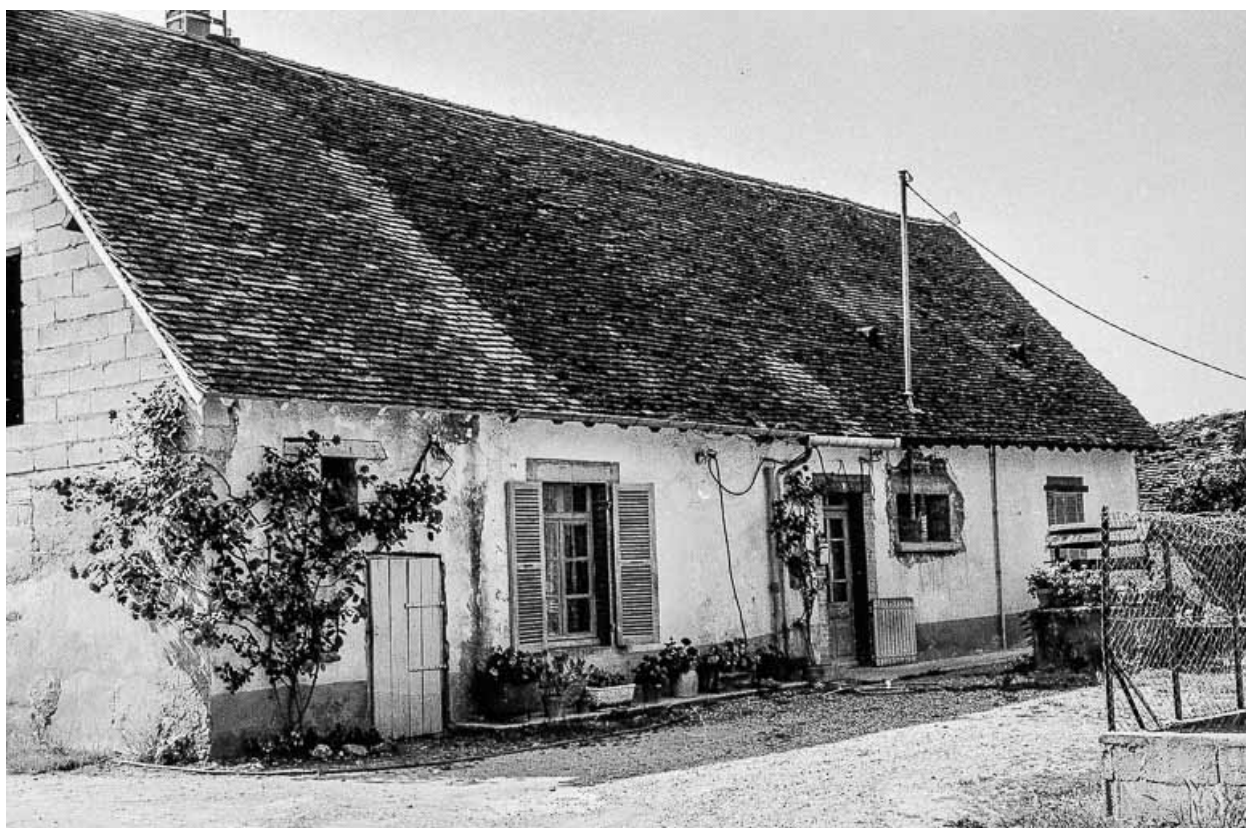
Ferme cadastrée 1984 B 545 : façade antérieure.
