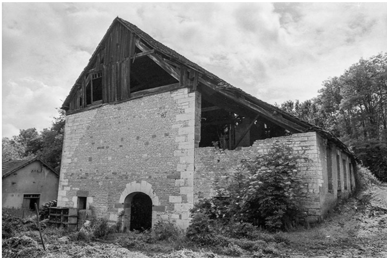
Bâtiment du haut fourneau en 1980.
