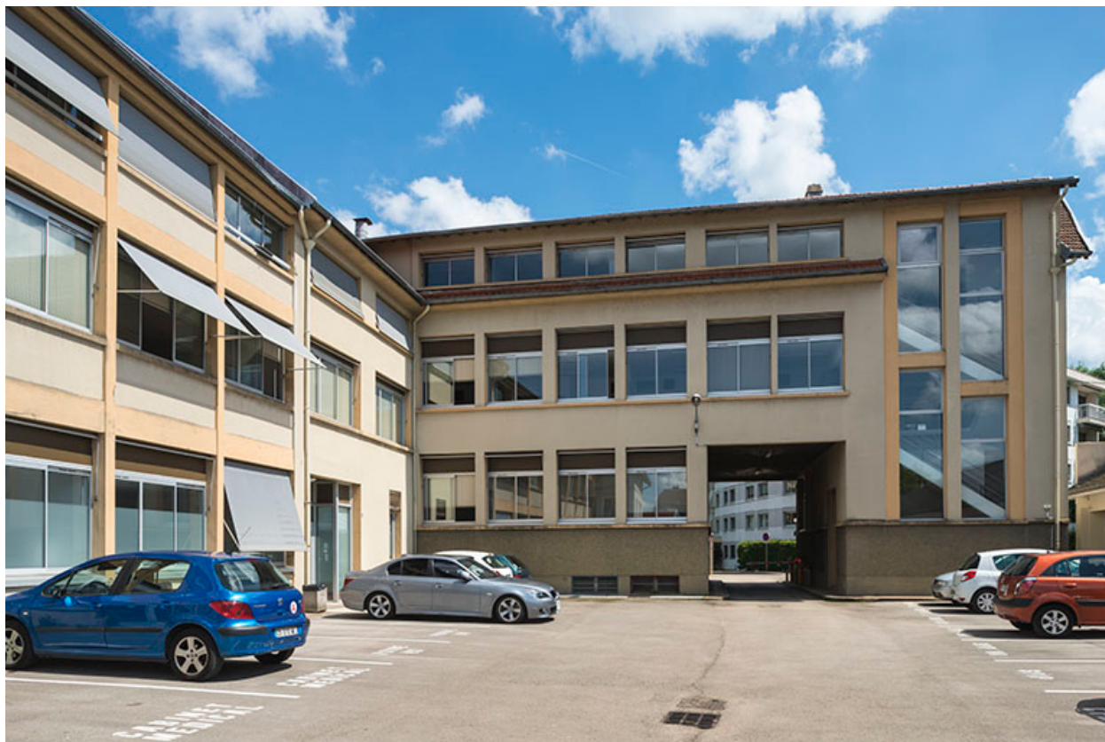
Bâtiment d'entrée. Façade nord.
