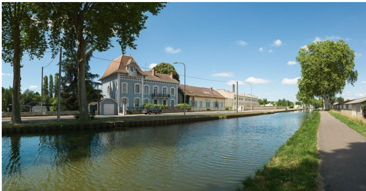
Les bâtiments de l'usine, rive gauche.
