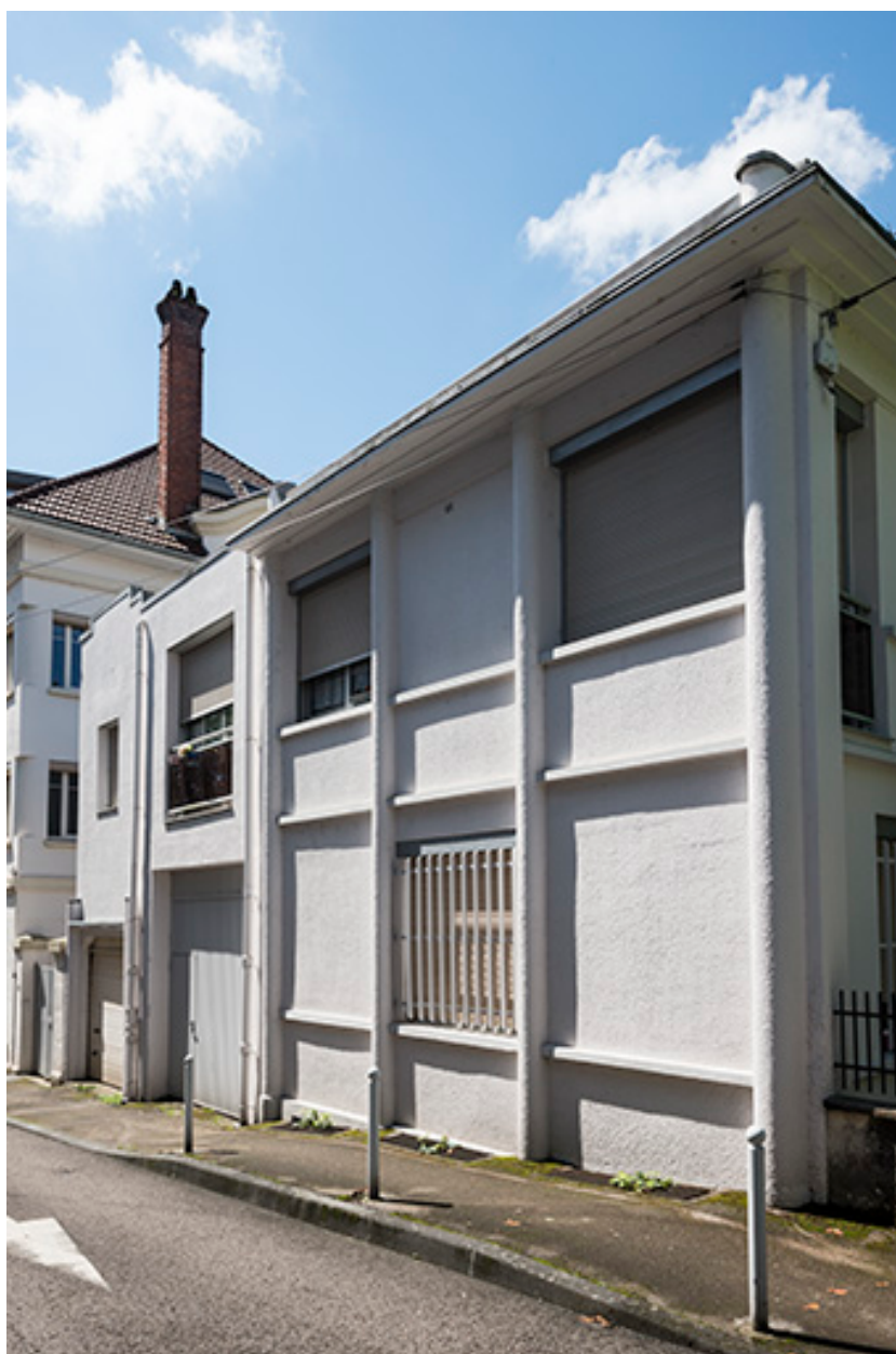
Façade antérieure vue de trois quarts droite.
