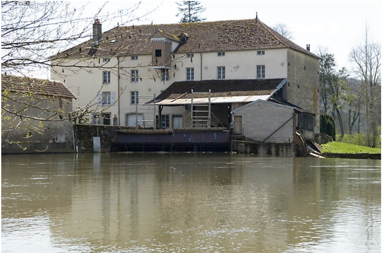
Façade antérieure depuis l'amont.
