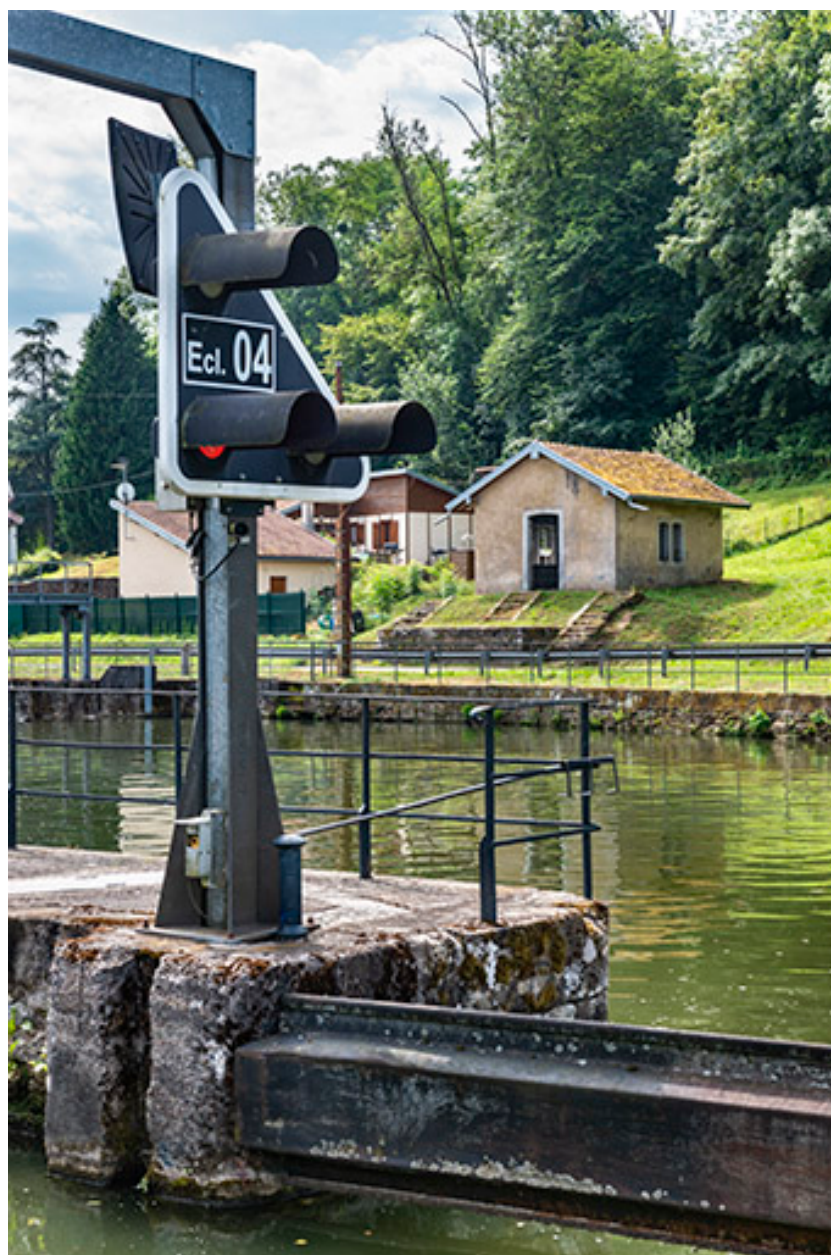
Le panneau de signalisation de l'écluse et le magasin à aiguilles du barrage.
