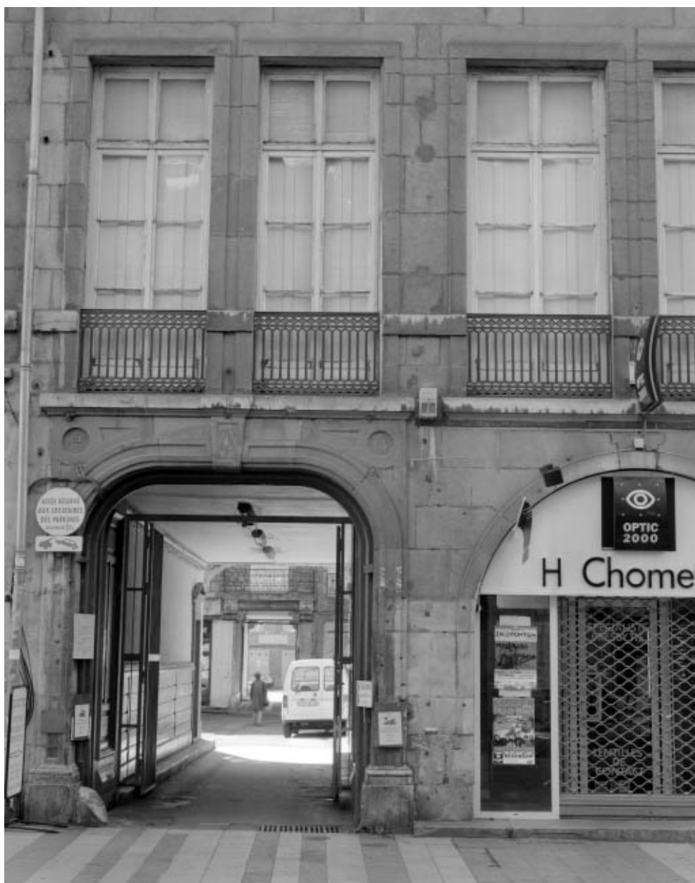
Façade sur rue, détail de l'entrée cochère.
