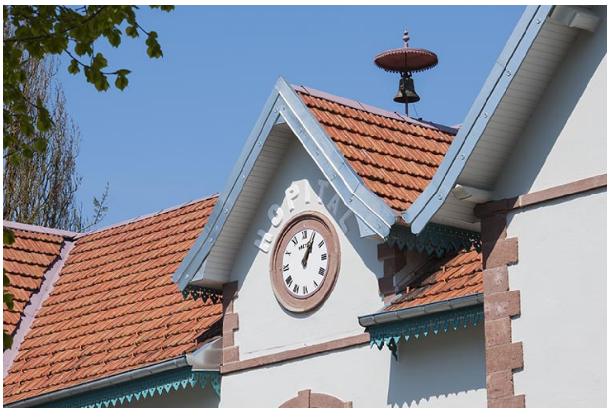
Façade antérieure. Détail du pignon.
