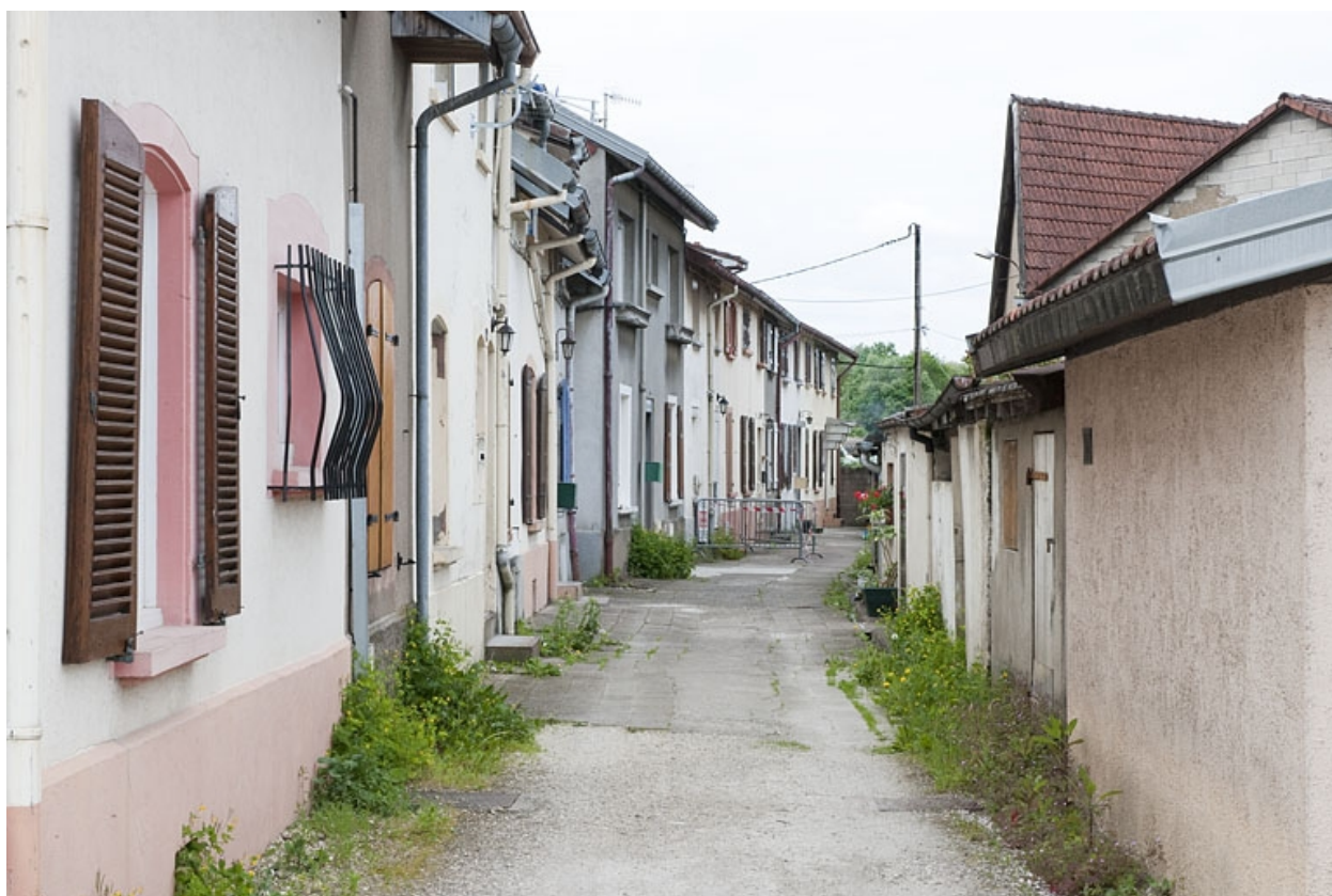
Façades ouest de la cite ouvrière.
