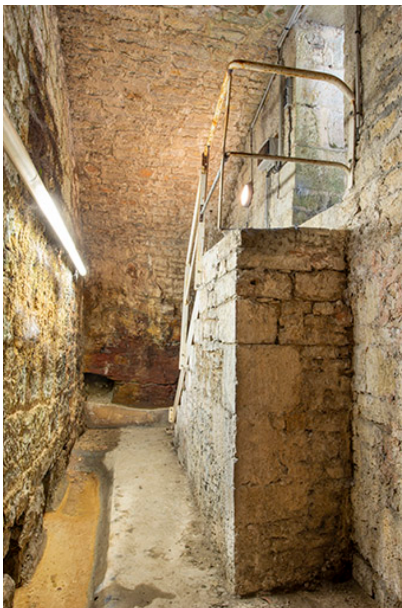
Pièce de captage des sources.
