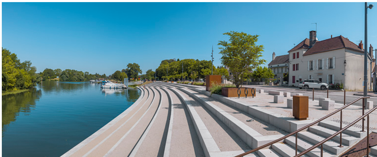
Vue d'ensemble des quais après leur réaménagement.
