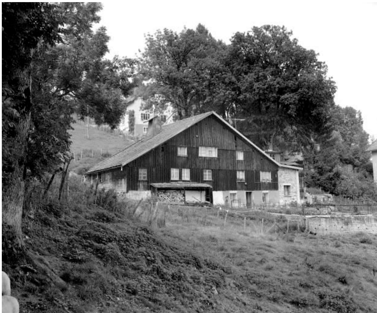
Grand'Combe-Châteleu, ferme située au lieu-dit Les Cordiers.
