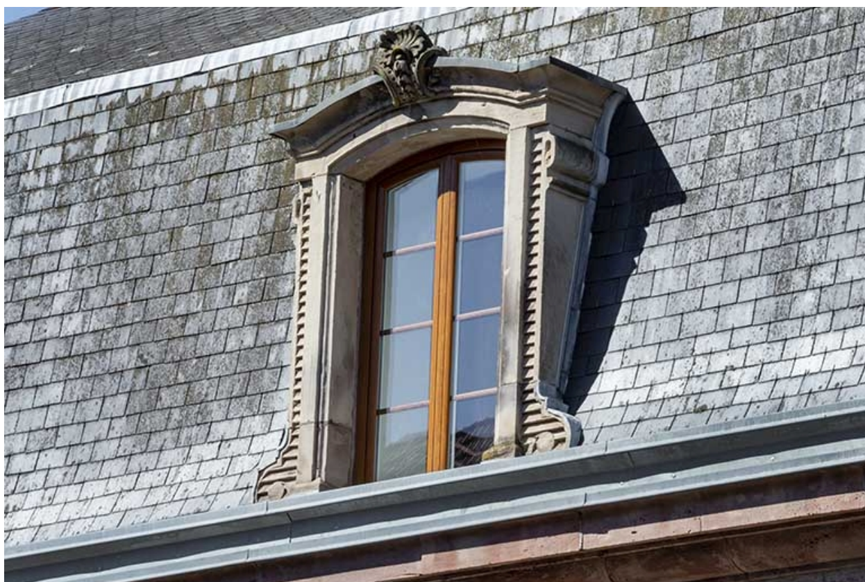
Maison Desgranges, lucarne est (lucarne centrale).
