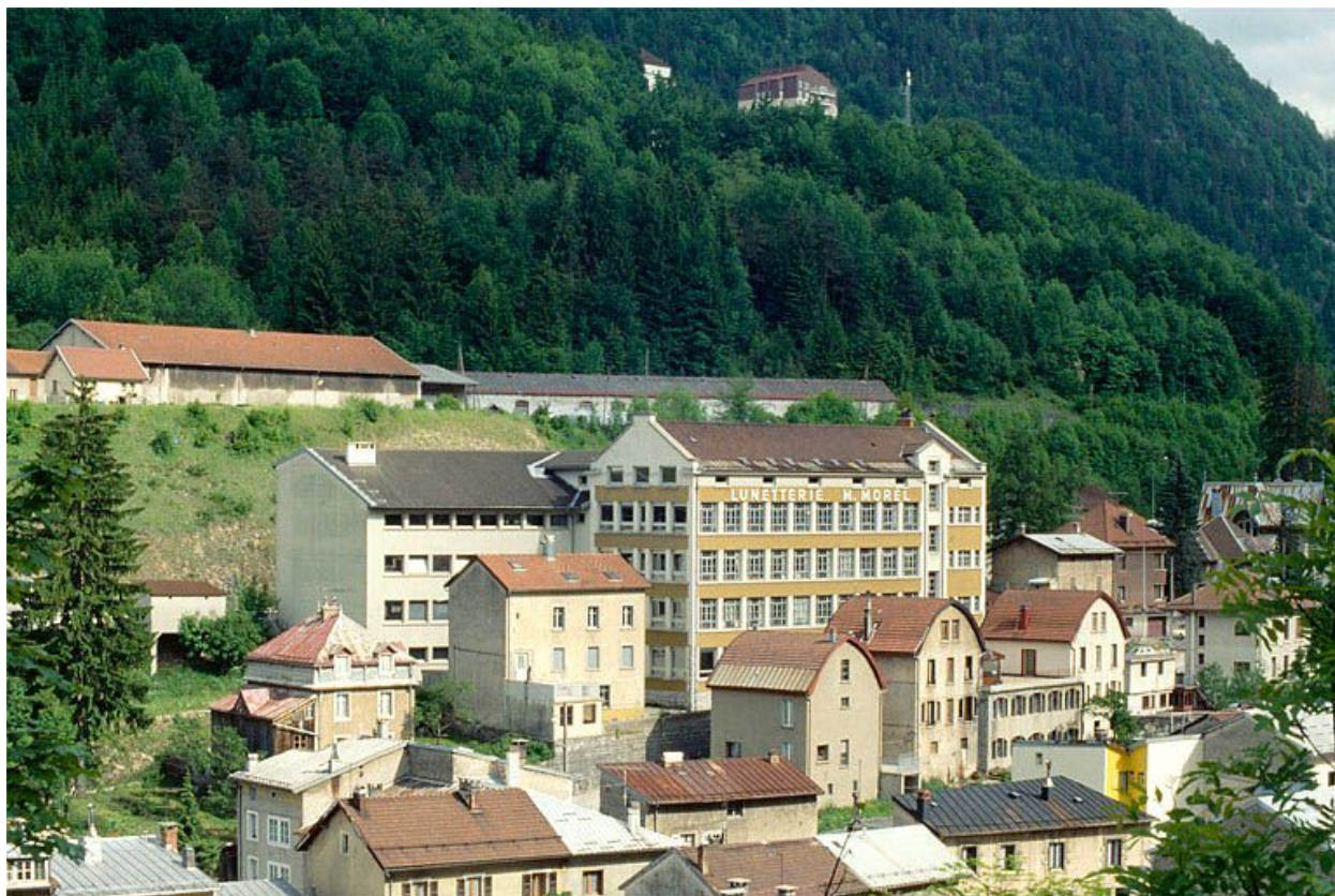
Vue d'ensemble de la façade postérieure.
